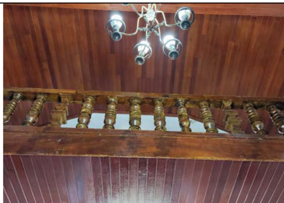
Foto 4: Perspectiva mostrando a balaustrada, o forro do nártex e o forro da nave, evidenciando a harmonia entre as partes estruturais e decorativas. Fonte: Alex Alves, 26 de setembro de 2024.
