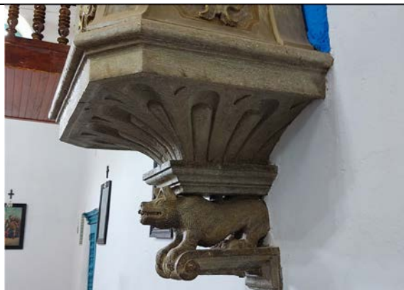
Foto 4: Embasamento de cantaria do púlpito, destacando a base da estrutura. Fonte: Alex Alves, 26 de setembro de 2024
