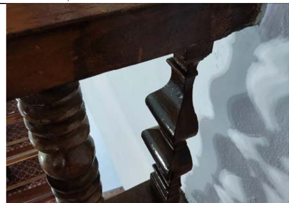
Foto 13: Peça da balastrada que quebra o padrão construtivo, possivelmente indicando substituição por material não original. Fonte: Alex Alves, 26 de setembro de 2024.
