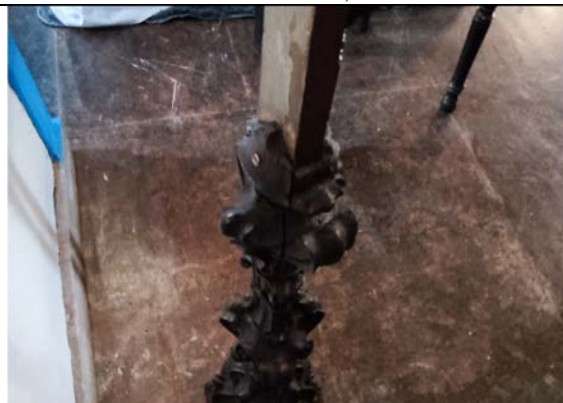
Foto 12: Na parte posterior, também é possível observar uma trinca, que sugere a necessidade de monitoramento e intervenções preventivas para evitar danos maiores. Fonte: Alex Alves, 26 de setembro de 2024.
