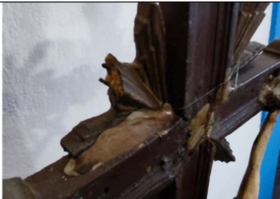
Foto 4: Adornos da cruz, que também foram colados com durepoxi, indicando intervenções anteriores para preservar os detalhes ornamentais. Fonte: Alex Alves, 26 de setembro de 2024.
