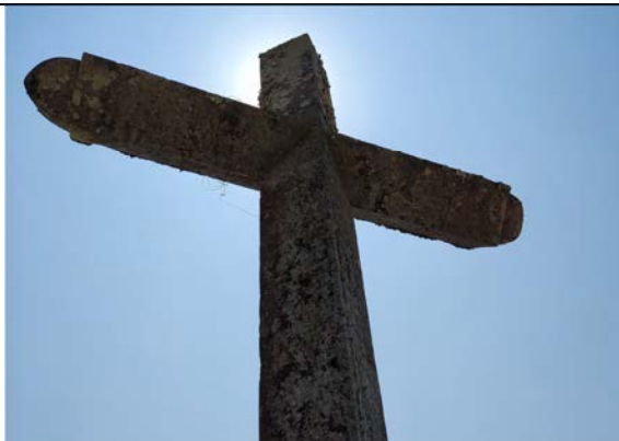
Foto 4: Outra visão do cruzeiro, onde se nota a presença de sujeiras aderidas e a formação de líquens, indicando a necessidade de conservação. Fonte: Alex Alves, 26 de setembro de 2024.
