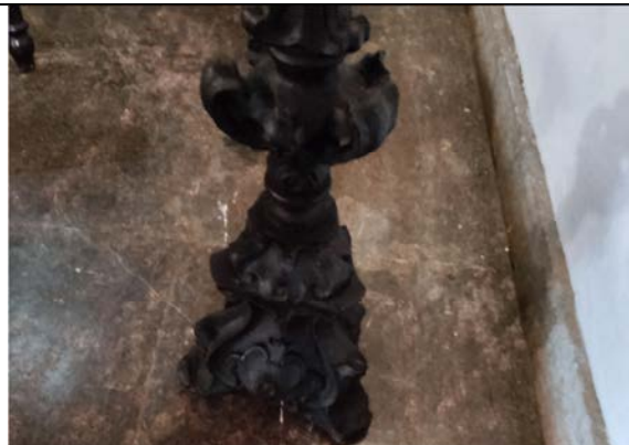
Foto 16: Outro ângulo do apoio ao chão da cruz, que também mostra detalhes recuperados com epóxi, evidenciando a continuidade das intervenções para garantir a preservação do monumento. Fonte: Alex Alves, 26 de setembro de 2024.
