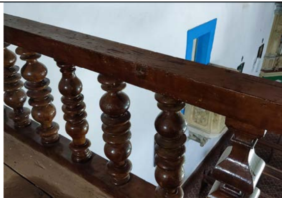
Foto 15: Visão geral da balastrada, destacando a uniformidade dos balaústres e o estado de conservação da madeira. Fonte: Alex Alves, 26 de setembro de 2024.
