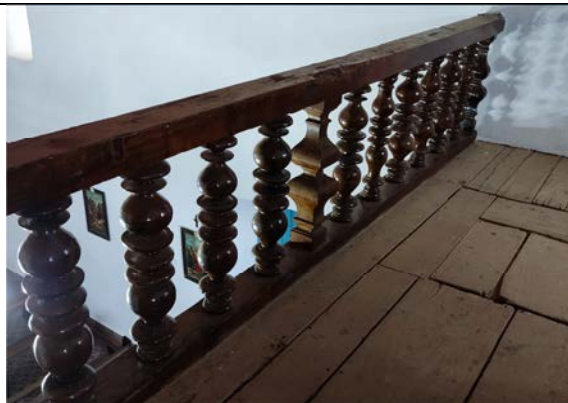
Foto 16: Outra visão geral da balastrada de madeira do coro, mostrando a integridade estrutural e o contexto decorativo. Fonte: Alex Alves, 26 de setembro de 2024.
