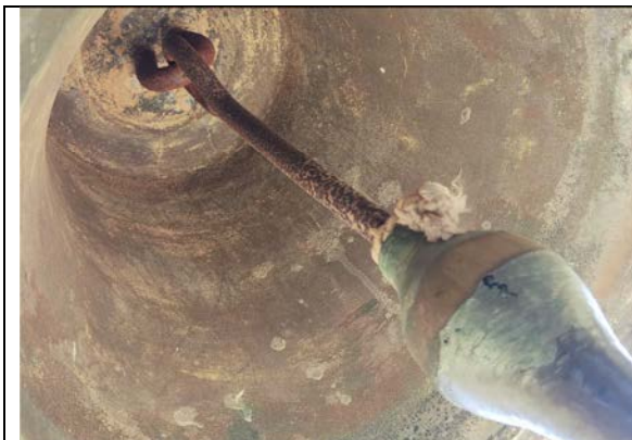
Foto 3: Vista interna do sino, onde se pode observar o badalo e a presença de manchas e desgastes, resultado do uso contínuo e da exposição às intempéries. Fonte: Alex Alves, 26 de setembro de 2024.
