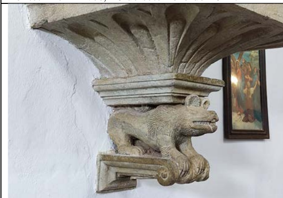
Foto 7: Vista do embasamento de cantaria do púlpito, apresentando sujidades aderidas que podem indicar a necessidade de limpeza. Fonte: Alex Alves, 26 de setembro de 2024.
