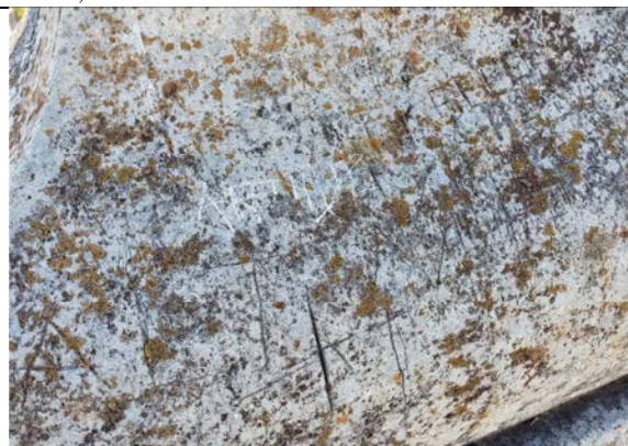
Foto 7: Riscos visíveis na pedra do embasamento, com inscrições não muito claras; algumas são profundas e outras aparentam ser recentes. Fonte: Alex Alves, 26 de setembro de 2024.
