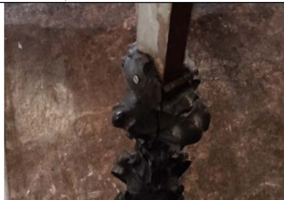
Foto 11: Fixação de partes da cruz, que foram feitas com parafusos, evidenciando as medidas adotadas para garantir a integridade estrutural. Fonte: Alex Alves, 26 de setembro de 2024.
