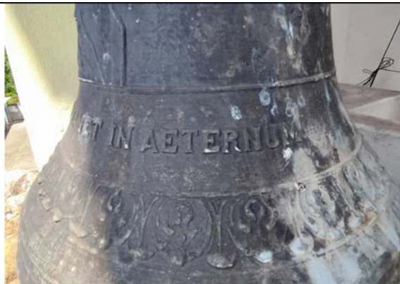
Foto 4: Inscrição na lateral do sino, com presença de manchas brancas. Fonte: Alex Alves, 26 de setembro de 2024.
