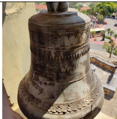
Foto 4: Vista geral do sino, evidenciando manchas brancas e de oxidação que cobrem toda a superfície, indicando deterioração devido à ação do tempo e das condições ambientais. Fonte: Alex Alves, 26 de setembro de 2024.
